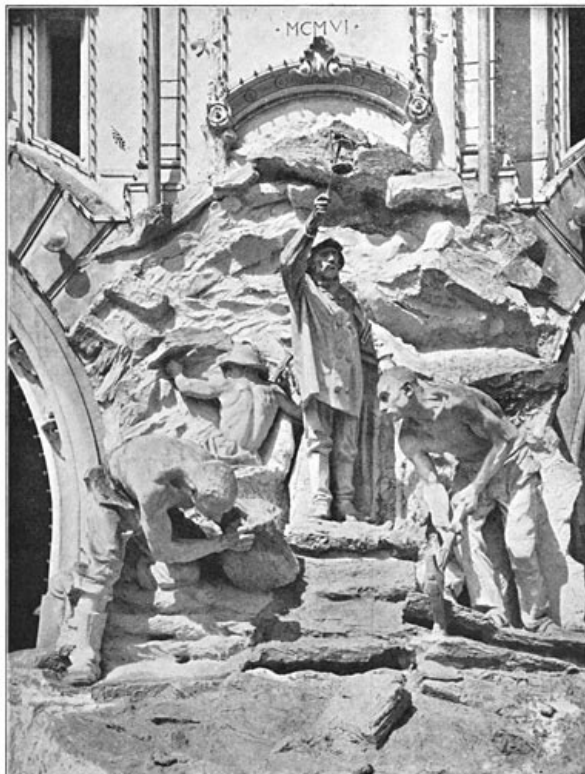
De arbeid in den tunnel. Groep van den beeldhouwer Butti.
