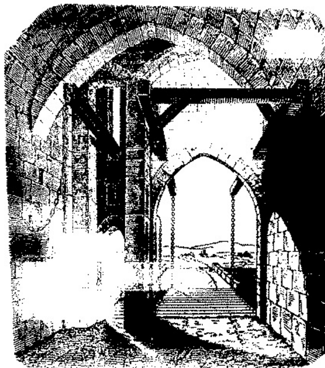
Figura 231: Interior de uma porta com ponte levadiça
