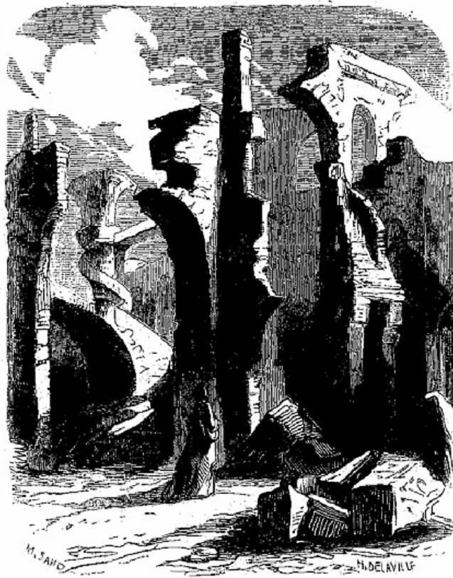
La masse de constructions ruinées...
