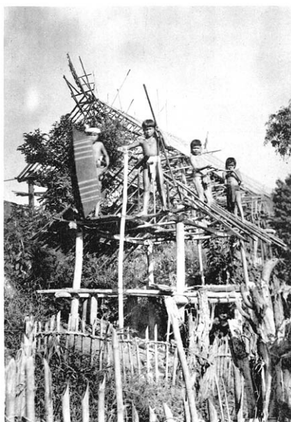
Kajanknaben auf dem Gerüst ihres selbstgebauten Häuschens.
