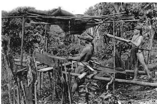
Herstellung von Schindeln.
