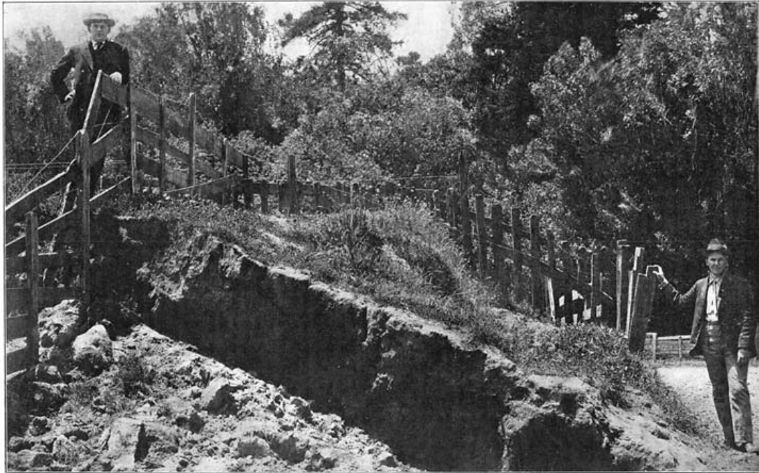
Een klein gedeelte van de scheur, wier vorming de aardbeving heeft veroorzaakt, bij Fort Rey, ten noorden van San Francisco.
