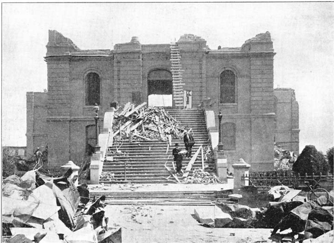
Het Court-house, het centrale gebouw van Santa Rosa na de aardbeving. De bovenverdieping is binnen in het gebouw omlaag gestort.
