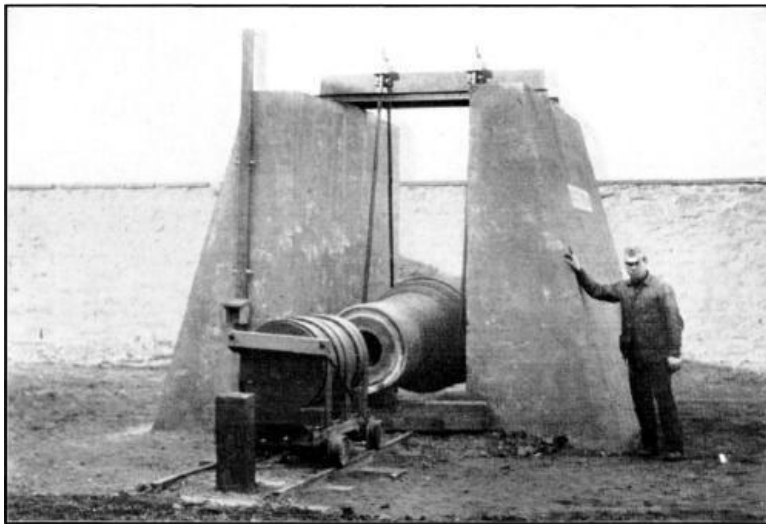
FIG. 3.—BALLISTIC PENDULUM.
