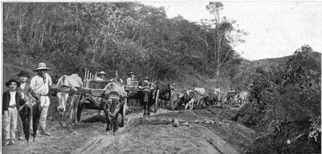
De spoorweg zal de ongebaande wegen vervangen.
