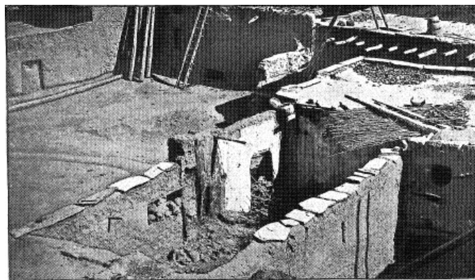
PLATE XCVI. ADOBE WALLS IN ZUNI.
