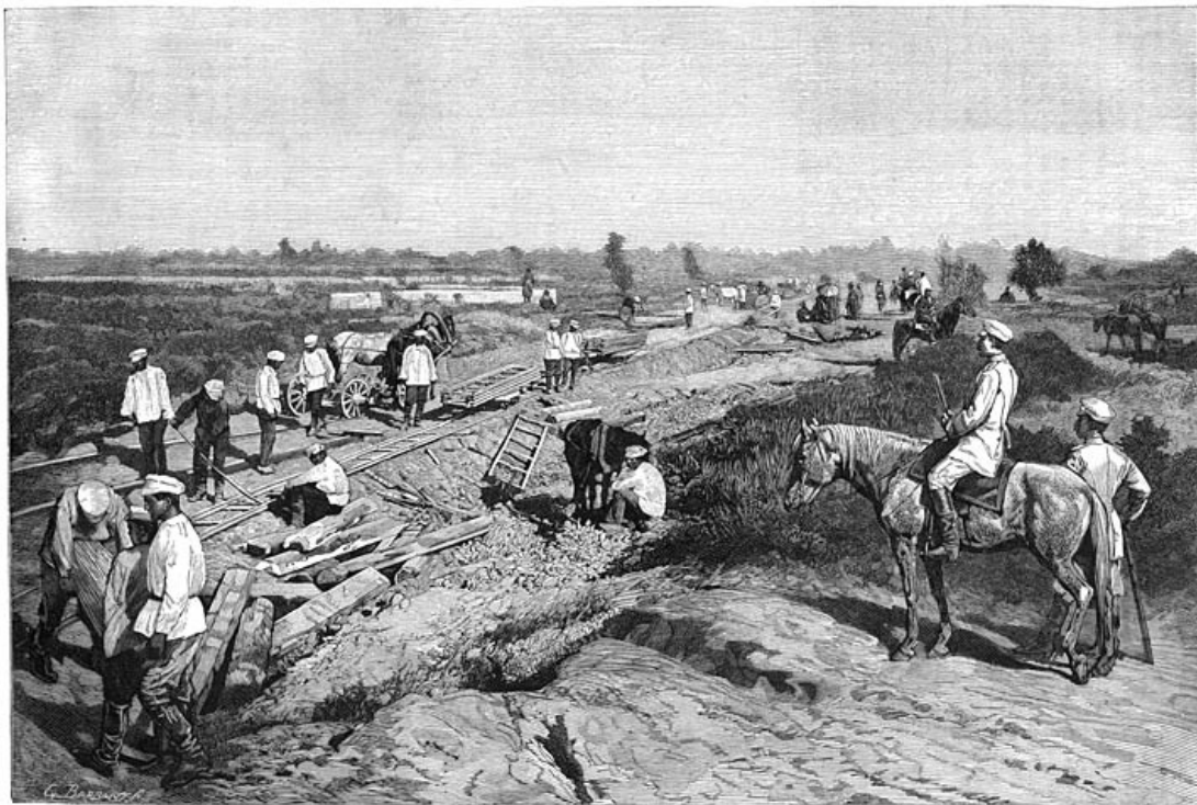
Het leggen der rails.
