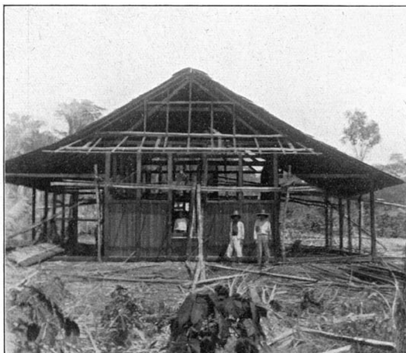
Het tijdelijke administrateurshuis in aanbouw.
