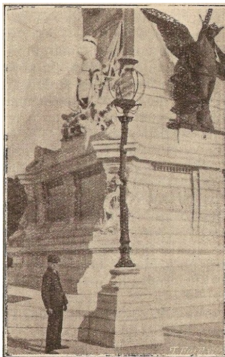
Candieiro furado pelas balas na Avenida da Liberdade
