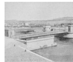
PONT TOURNANT SUR LE CANAL DU MIDI A CETTE.—Les canaux ne sont pas toujours assez profondément creusés pour que les bateaux puissent passer sous les arches des ponts. Afin que les bateaux ne soient pas arrêtés au passage, on a inventé les ponts tournants qui s'ouvrent par la moitié ou tournent tout entiers sur eux-mêmes.—Cette, qui par son canal du Midi communique avec l'océan, est, après Marseille, notre port le plus important sur la Méditerranée. Elle fait un grand commerce de vins et eaux-de-vie et compte 30,000 hab.
