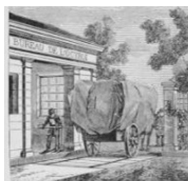
OCTROI ET BASCULE.—AUX portes de toutes les villes sont des bureaux d'octroi où l'on doit payer les droits d'entrée sur les marchandises.—Pour peser les voitures et fixer le poids des marchandises qu'elles portent, on les fait passer sur la plate-forme d'une bascule. Cette plate-forme, à l'aide d'un levier, soulève le fléau d'une balance qui se trouve à l'intérieur du bureau d'octroi, et l'employé lit, sur le bras de fer, le nombre de kilogrammes.
