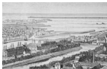
CHERBOURG ET SA DIGUE.—La rade de Cherbourg était une des plus belles de la Manche, mais elle était ouverte du côté de la mer et exposée aux tempêtes ou à l'attaque des ennemis. C'est pour la fermer qu'on a construit cette immense digue, œuvre unique en son genre, qui est une sorte d'île faite de main d'homme et au milieu de laquelle s'élève un fort. Cherbourg est maintenant un des chefs-lieux des cinq arrondissements maritimes dans lesquels on a divisé nos côtes.
