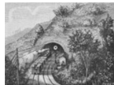
TUNNEL DE LA NERTHE, PRÈS DE MARSEILLE.—Un tunnel est un passage pratiqué sous terre ou à travers une montagne, dans lequel s'engagent les trains de chemin de fer. Le plus grand tunnel de France a été longtemps celui de la Nerthe, qui a près de 5 kilomètres de longueur. Un autre tunnel, plus grand encore, a été construit récemment pour mettre en communication la France et l'Italie: c'est celui du mont Cenis, dont la longueur dépasse 12 kilomètres.
