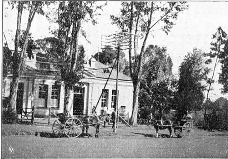
Het postkantoor. Voor het kantoor twee karretjes wachtende op de post voor de buitenkantoren.
