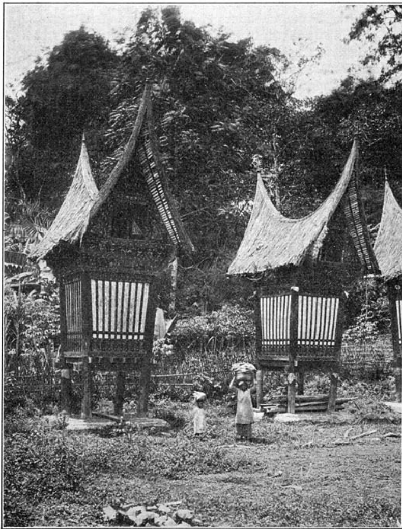
De Minangkabauer bouwt een rijstschuur die gelijk op een wieg, op palen gezet en spits overkapt.
