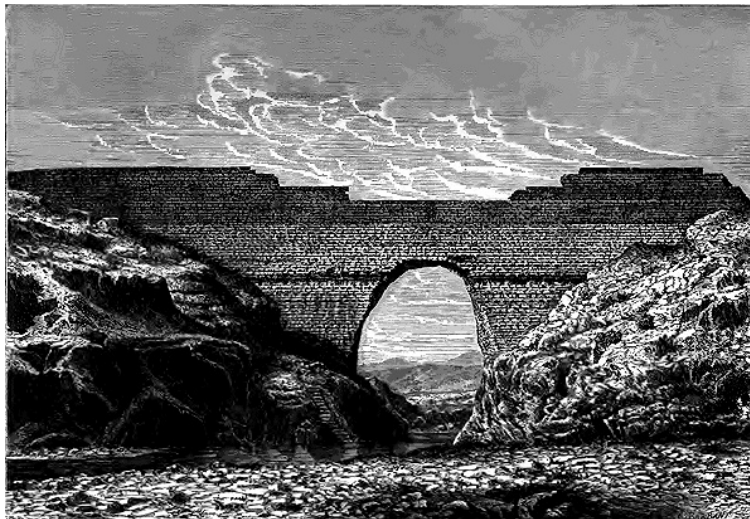
DIGUE RUINÉE DE LORCA.
