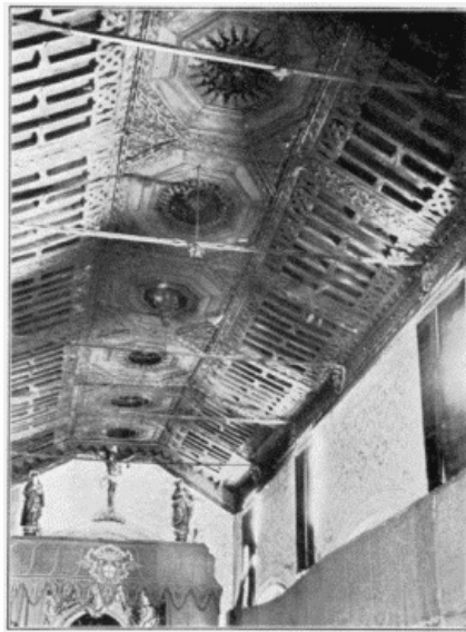
FIG. 49. CAMINHA. ROOF OF MATRIZ.
