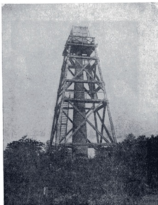
Signal de Saint-Antoine, pylône en briques, construit pour le Service géographique de l'Armée.
