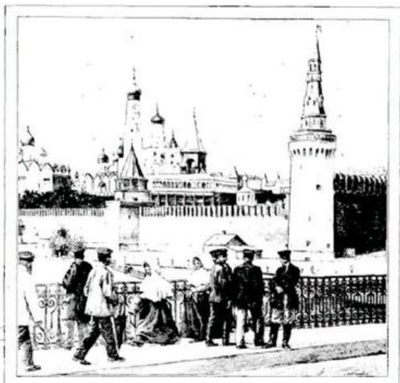
LE MUR D'ENCEINTE DU KREML,
