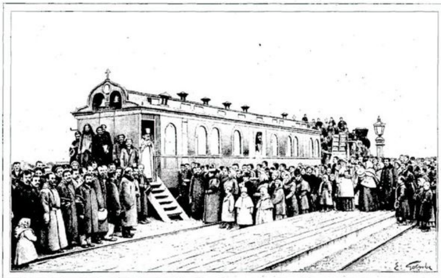
UN TRAIN DE CONSTRUCTEURS ÉTAIT REMISÉ LÀ, AVEC SON WAGON-CHAPELLE (page 225).—PHOTOGRAPHIE DE M. A. N. DE KOULOMZINE.
