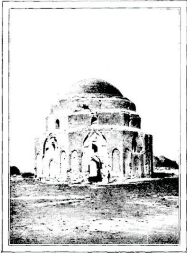
LE «DÔME DE DJABALIA», RUINE DES ENVIRONS DE KIRMAN, ANCIEN SANCTUAIRE OU ANCIEN TOMBEAU (page 321).—D'APRÈS UNE PHOTOGRAPHIE.
