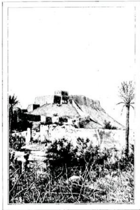
DES FORTS ABANDONNÉS RAPPELLENT L'ANCIENNE PUISSANCE DU BALOUTCHISTAN.— D'APRÈS UNE PHOTOGRAPHIE.
