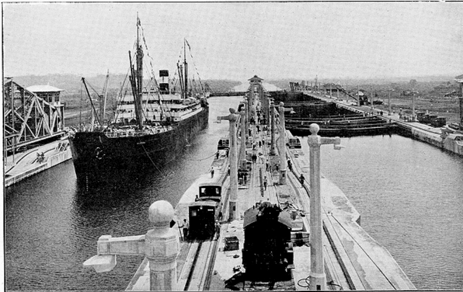
Le Cristobal vient de franchir l'écluse supérieure pour pénétrer, halé par une locomotrice, dans le lac artificiel de Gatun.
