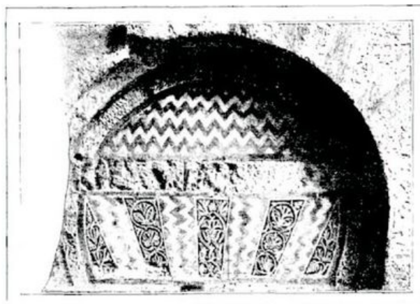
DÉTAIL D'UNE PORTE DE LA MOSQUÉE DE CORDOUE.—D'APRÈS UNE PHOTOGRAPHIE.
