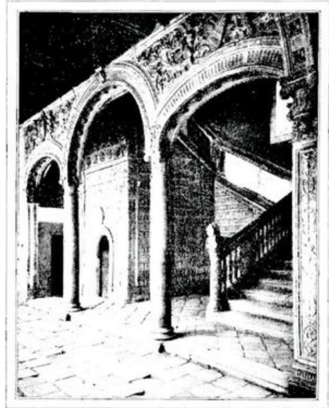
ESCALIER DE L'HÔPITAL DE SANTA CRUZ (page 604).—D'APRÈS UNE PHOTOGRAPHIE.
