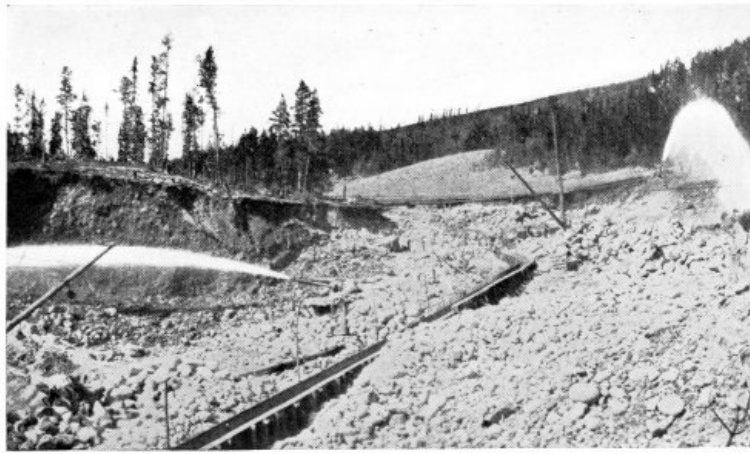
HYDRAULICKING IN COLORADO.
