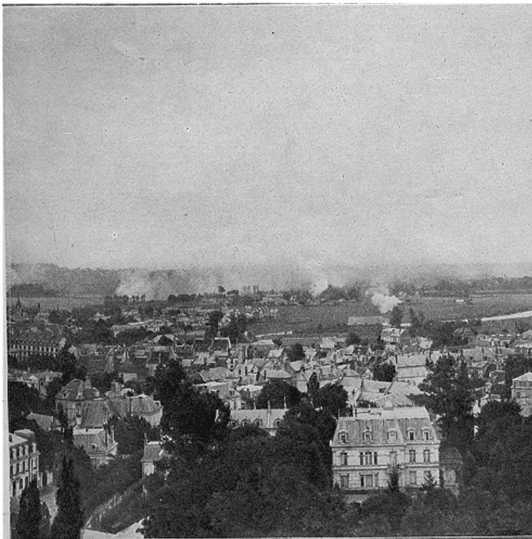
Commencements d'incendie provoqués par les obus.
