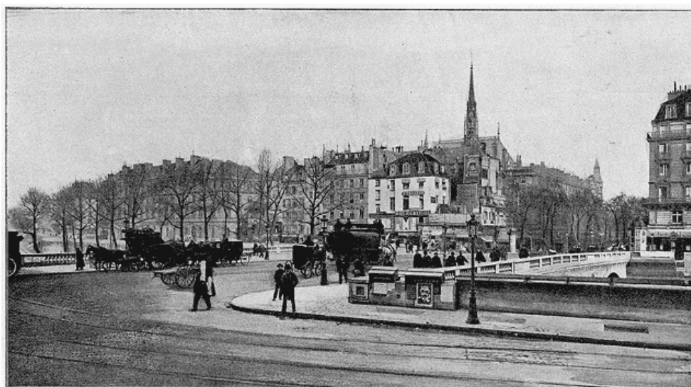
Aspect actuel du Palais de justice et des vieilles maisons qui y sont enclavées, à l'angle du boulevard du Palais et du quai des Orfèvres.
