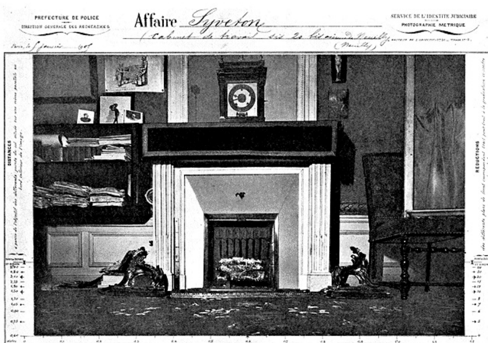
LA CHEMINÉE A GAZ DU CABINET DE TRAVAIL DE M. SYVETON.
