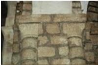
071. Saint-Pair-sur-Mer. Détail du pilier nord de la tour. S'appuyant sur un dossieret, un pilastre cantonné de deux colonnes engagées est surmonté d'une imposte moulurée en forme de bandeau chanfreiné. L'imposte forme aussi le tailloir des chapiteaux. La corbeille des chapiteaux est sculptée de crochets d'angle taillés dans le granit. Photo d'Alain Dermigny. [Alain-037]
