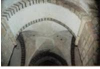
069. Saint-Pair-sur-Mer. La tour romane. A l'intérieur, la tour repose sur quatre piliers massifs parfaitement symétriques supportant quatre arcs fourrés et légèrement brisés. Ces piliers déterminent la voûte d'arêtes située sous la tour. Photo d'Alain Dermigny. [Alain-036]
