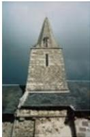
026. Bréville. L'étage et la flèche de la tour. L'étage est percé sur chaque face d'une ouverture longue et étroite. Au-dessus s'élève une flèche octogonale de pierre aux angles adoucis par des tores, avec un petit gâble à fines colonnettes situé dans le prolongement de chaque ouverture. Photo d'Alain Dermigny. [Alain-011]
