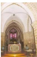
148. Genêts. La croisée du transept romane. Les quatre piliers sont parfaitement symétriques, avec deux côtés présentant une surface plane sans aucune mouluration et deux autres côtés présentant deux colonnes jumelles engagées sur dossier et recevant les arcs brisés. Dans l'un des angles de chaque pilier, une colonne engagée reçoit la retombée d'une des arêtes de la voûte. Chaque pilier est surmonté d'une large imposte moulurée en forme de bandeau chanfreiné. Photo de Claude Rayon. [Claude-46]
