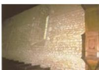
126. Dragey. Le mur nord de la nef (intérieur). Mené par les habitants du village, le patient travail consistant à gratter l'enduit a permis de mettre en valeur l'appareil en arêtes de poisson, signe de l'ancienneté de l'église. L'enduit intérieur ne recouvre plus que le dernier quart supérieur des murs. Photo de Claude Rayon. [Claude-37]
