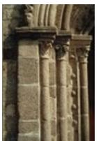
209. Portail de Sartilly. Les colonnettes de gauche. De chaque côté du portail, les trois voussures reposent sur trois colonnettes engagées, par le biais d'une imposte moulurée d'un cavet. La partie carrée de l'imposte est ornée d'une petite moulure en creux. L'imposte se prolonge au-dessus du pilastre extérieur sur lequel repose l'archivolte. Photo d'Alain Dermigny. [Alain-113]
