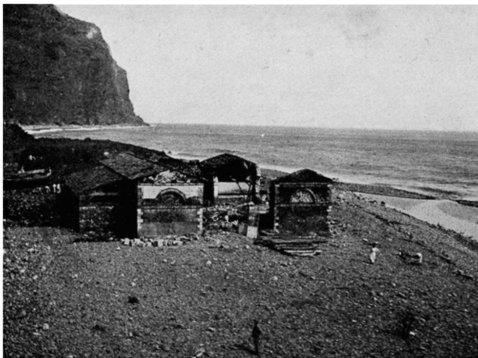
L'abattoir de Saint-Denis de la Réunion après le passage du dernier cyclone.--Phot. E. Chardon.
