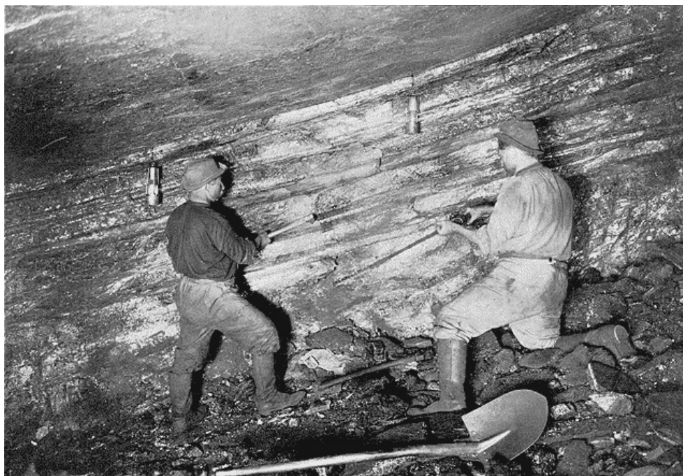
Au front de taille: havage à la main.
