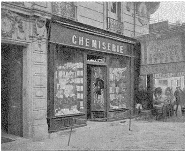
La chemiserie Clément, avenue de la République, après l'explosion.
