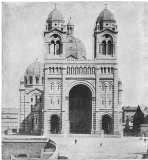
Photo, Neurdein. FIG. 126.—CATHEDRAL, MARSEILLES. (VAUDOYER AND ESPERANDIEU.)
