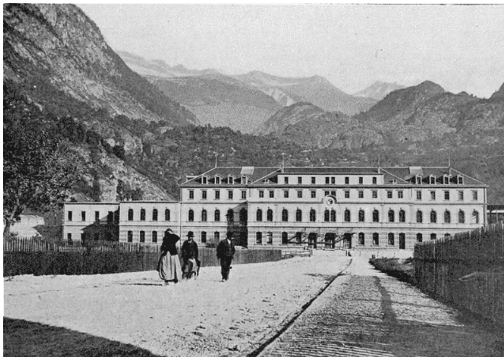
Une nouvelle grande gare pour le trafic international: la gare de Brigue (Suisse).
