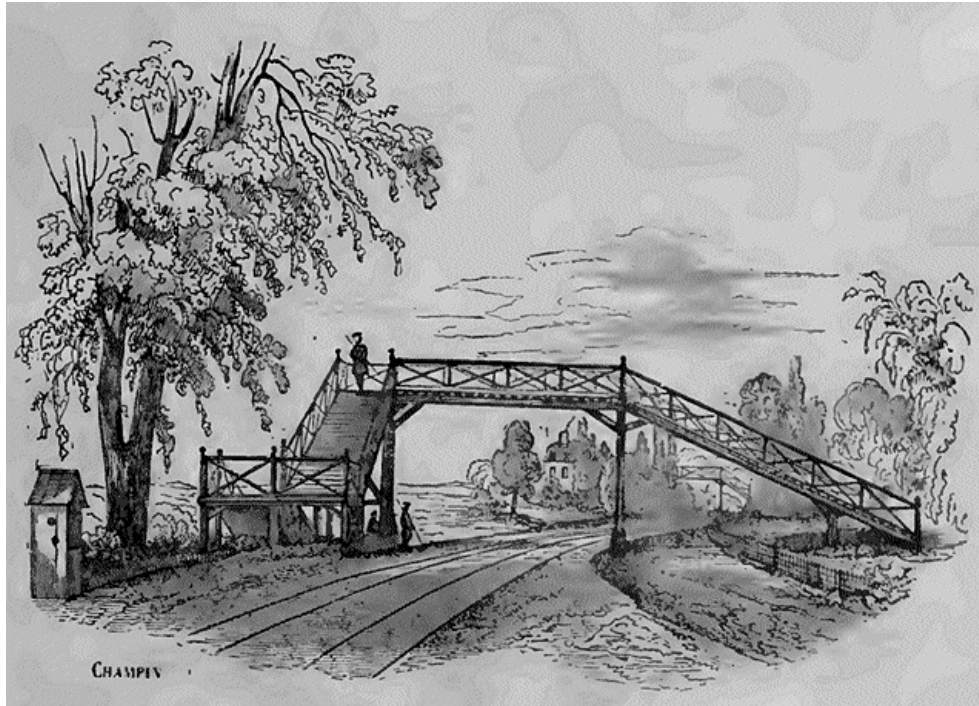
(Passerelle près du château de Trousseau.)
