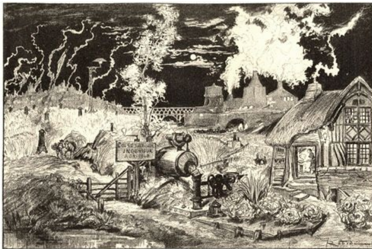
ADDUCTION ET DISTRIBUTION DU FEU CENTRAL.— TRANSFORMATION DE L'AGRICULTURE, EMPLOIS INDUSTRIELS ET DE MÉNAGE
