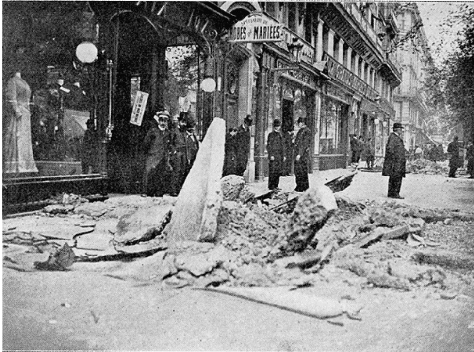
Le trottoir du boulevard de Sébastopol éventré par une explosion de gaz.
