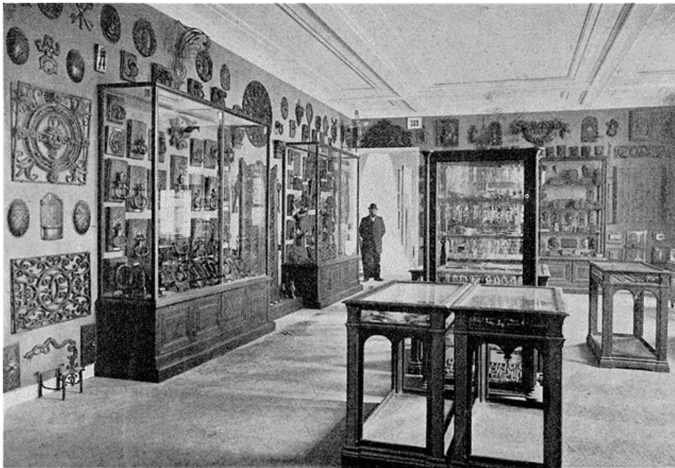
La collection de ferronnerie de M. Le Secq des Tournelles.
