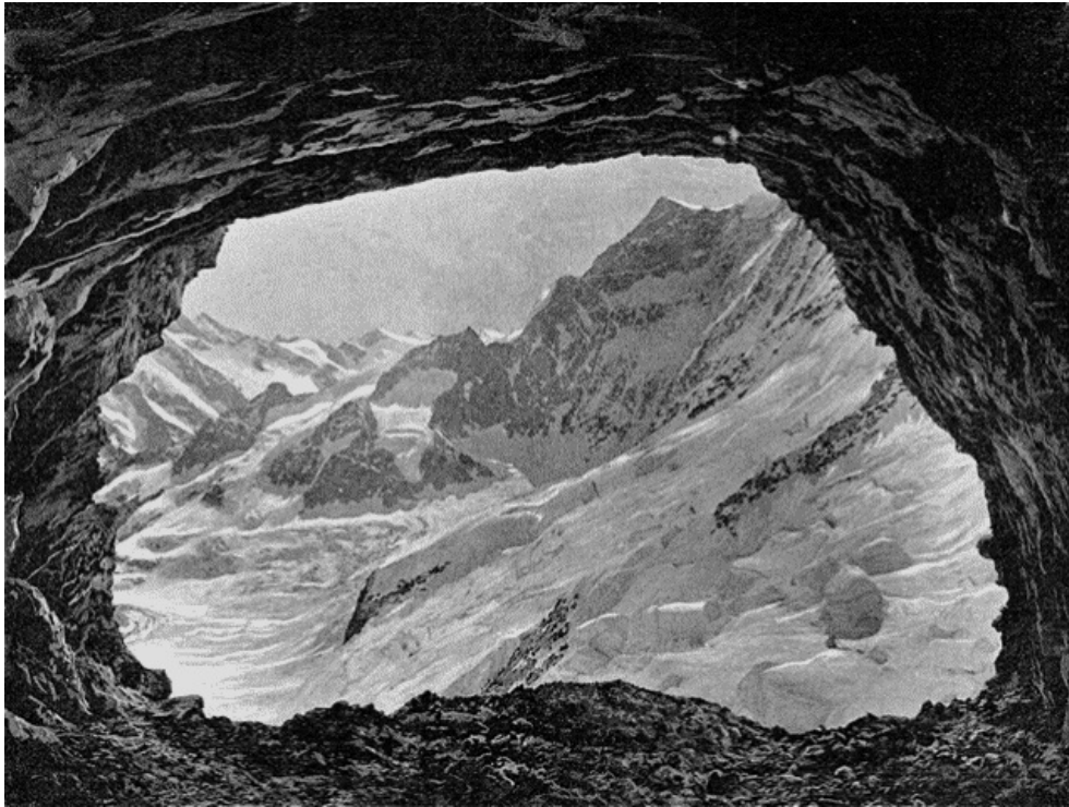
La Mer de glace, vue d'une des "fenêtres" ouvertes au flanc de la Jungfrau, pour le chemin de fer souterrain en construction.--Phot. S. Herzog.
