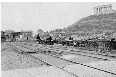
Wagons brûlés sur lesquels sont tombés les rails de la voie aérienne.
