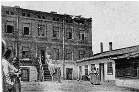
Brèche d'entrée dans la façade
