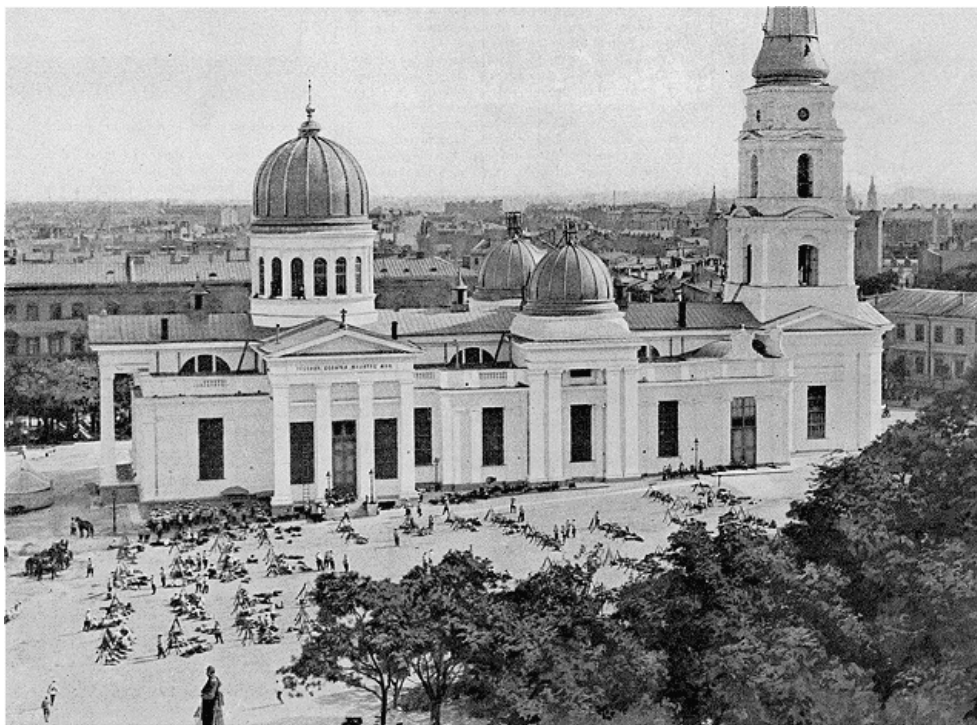
Vue de la place du Sobor (cathédrale d'Odessa), occupée par la troupe, pendant l'état de siège.--Des ouvriers couvreurs travaillent, malgré les événements, sur les toits de l'église.
