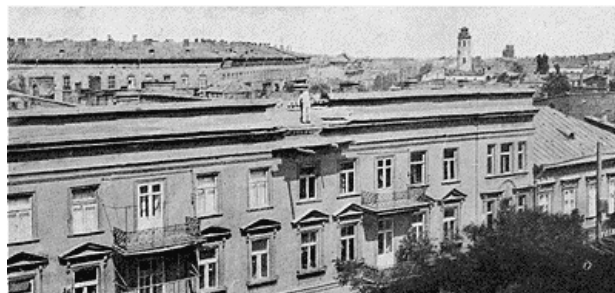
Six jours après le tir du Kniaz-Potemkine : la brèche de la maison de la rue Niejnskaïa est réparée.
