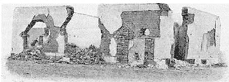
**Effet de neuf projectiles de 75 millimètres chargés à schneidérite sur une maison située à 1.000 mètres de distance.**
