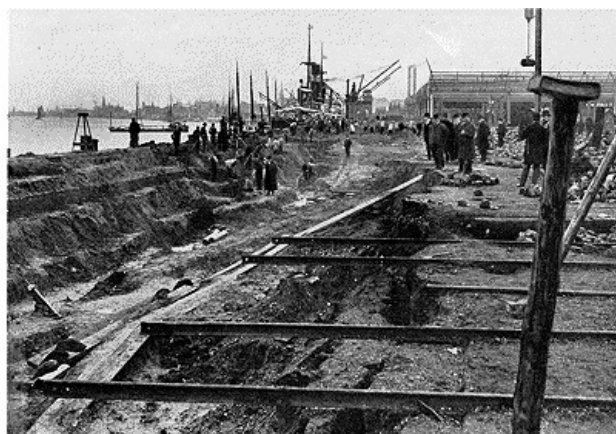
A Anvers: une crevasse produite par le glissement des quais dans le port.--Phot. A. Pierre.
