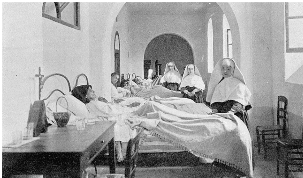
APRÈS LE TREMBLEMENT DE TERRE.--Femmes blessées à l'hôpital de Catanzaro. --Phot. A. Croce.
