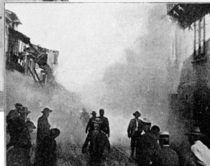
Chute du pavillon (3e phase): un nuage de poussière.
