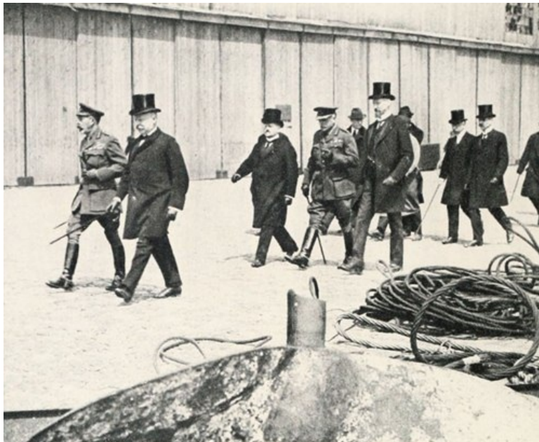
ZEEBRUGGE INSPECTING THE MOLE
