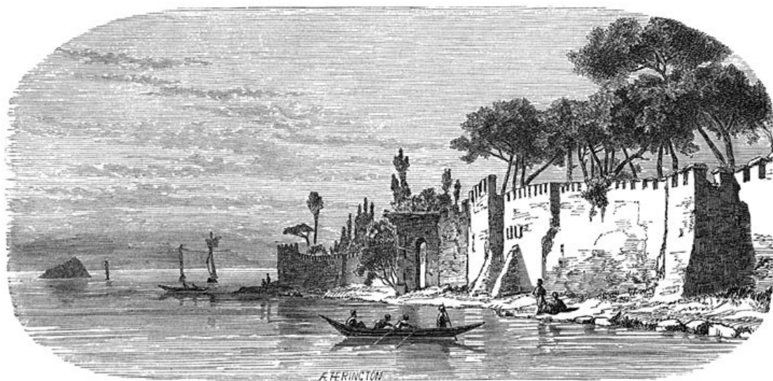
De muren van het serail.
