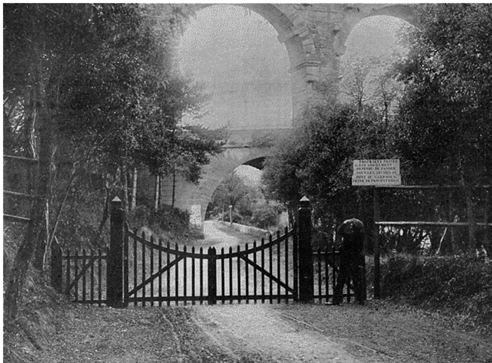
2.--Porte clôturant le chemin privé de la propriété de M. Calderon avec écriteau interdisant l'accès sous les arches du pont.--Phot. Ch. Bernheim.]
