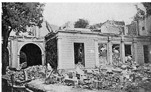
La maison de M. Thiers pendant sa démolition sous la Commune.
