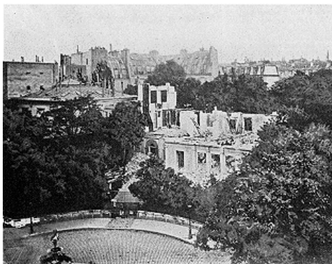
Vue d'ensemble des ruines de la maison de M. Thiers, place Saint-Georges, pendant la Commune.
