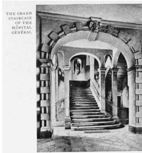
THE GRAND STAIRCASE OF THE HÔPITAL GÉNÉRAL
