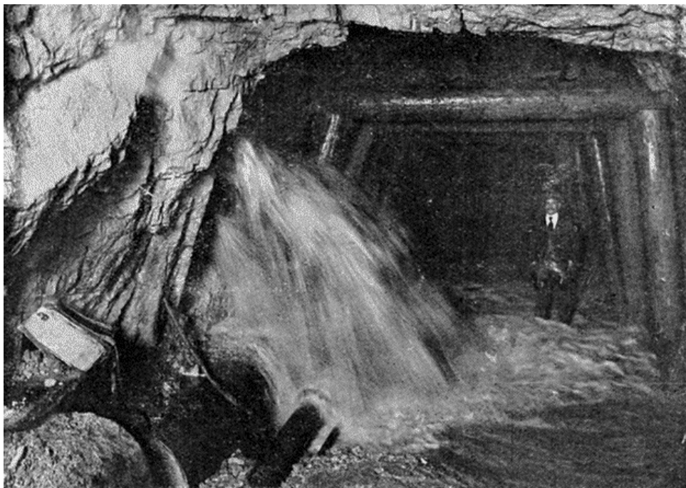
Invasion de l'eau dans la galerie d'avancement du tunnel du Mont d'Or (800 litres par seconde).
