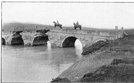
Le pont en pierre de Tchataldja, détruit par les Bulgares et provisoirement réparé par les Turcs.
