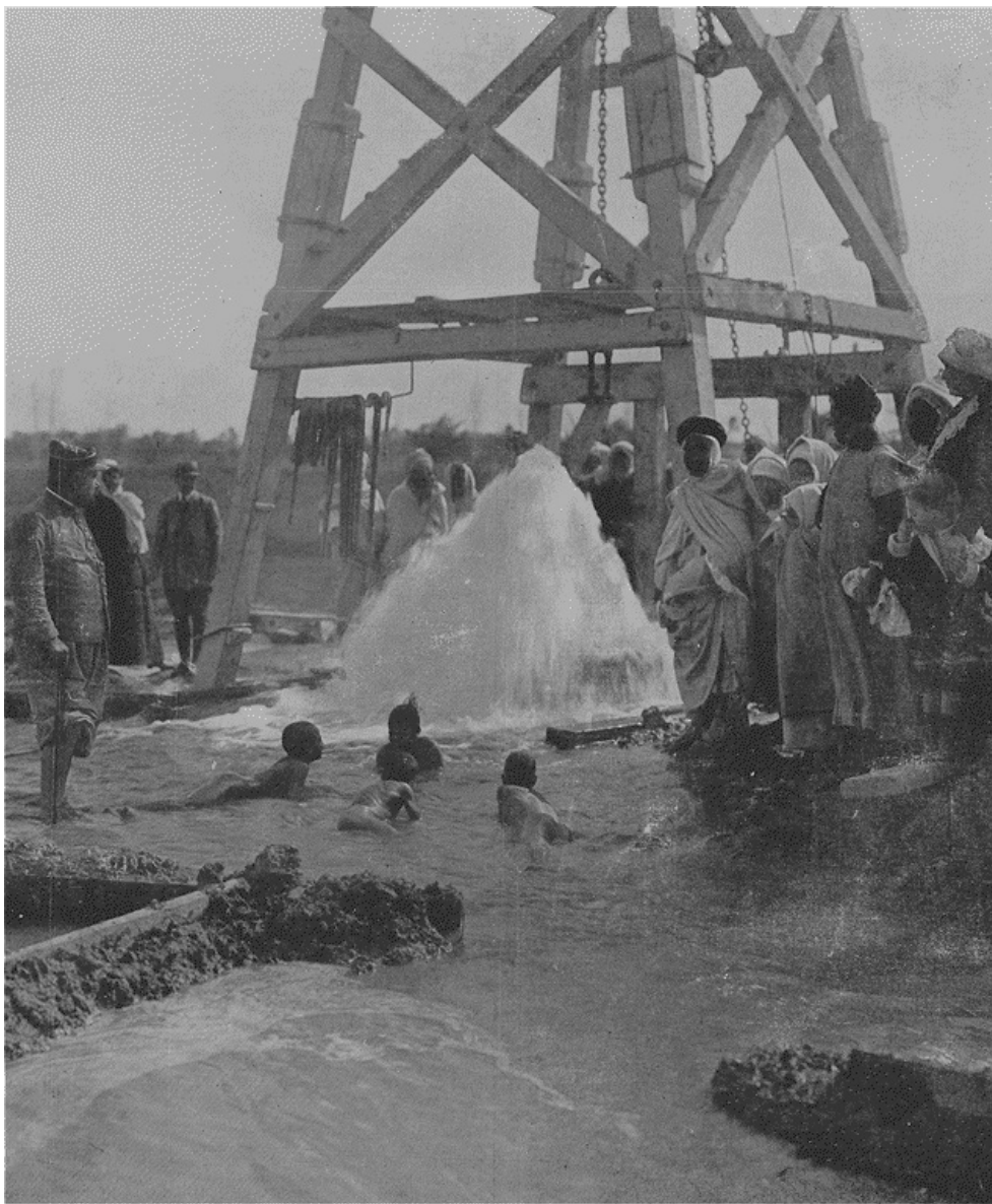
L'EAU JAILLISSANTE AU PAYS DU SABLE ET DU SOLEIL. --Percement du plus abondant des puits artésiens du monde (30.000 litres à la minute), à Tolga, dans le Sud-Algérien.--Phot. A. Bougault.
