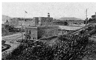
Vue d'ensemble de la prison de Saint-Quentin.
