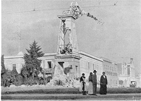
Pylône d'une horloge publique éventré par les obus.
