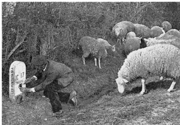
**Cantonnier rectifiant, au pochoir, le numérotage des routes sur les bornes kilométriques de la Nièvre.**
