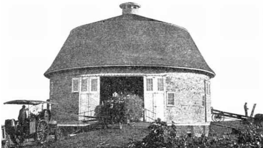
FIG. 2. FILLING THE SILO.
